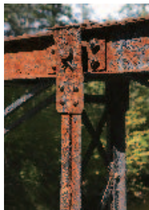
图 1-28 钢铁的腐蚀
